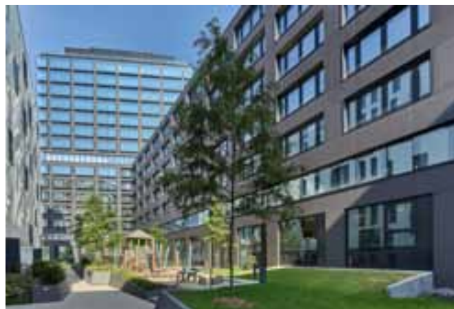
Mit der Marke Equitone zielt Etex auf Architekten. Hier: Der Campus Tower mit Equitone Fassadentafeln in der Hamburger HafenCity.
