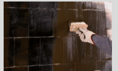
Grundierung je nach Witterung mit PCI BT 26 oder PCI BT 28
