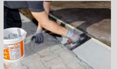
Aufbringen von PCI Aposan® zum Überbrücken von Höhenunterschieden bis 50 mm.
