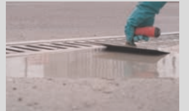
Anarbeiten an eine Rinne mit dem Epoxi-Vergussmörtel PCI Repaflow® EP Plus
