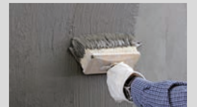
Aufbringen der mineralischen, sulfatbeständigen Abdichtung PCI Barraseal®
