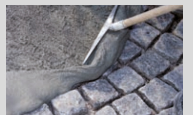
Einbringen des zementären Pflasterfugenmörtels PCI Pavifix® CEM auf eine vorgemastete Pflastersteinfläche
