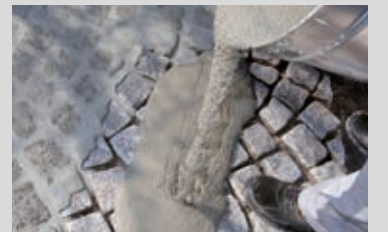
Einbringen des drainfähigen Pflasterfugenmörtels PCI Pavifix® 1K Extra auf der vorgemasteten Natursteinfläche
