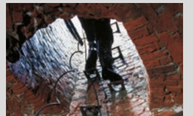
Setzen und Fixieren von Steigeisen im Bereich von Kanälen und Nachverfugen von Klinkerfugen mit PCI Polyfix® plus L
