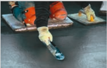
Estriche oberflächlich mit einer Traufel oder einem Flügelglätter glätten
