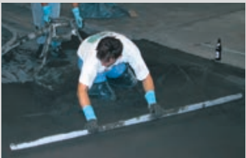
Estriche auf Dämm- und Trennlagen sind in homogenen Schichtdicken aufzubringen
