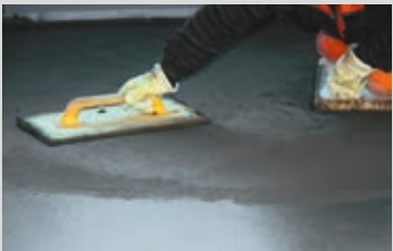
Gegebenenfalls ist unterhalb der Trennlage ein Ausgleich im Verbund aufzubringen
