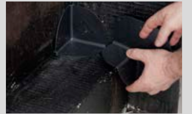
Kritische Ecken sicher absichten mit PVC-Formteilen PCI BT 45 und PCI BT 46
