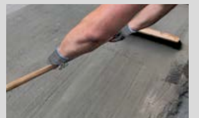
Ausführung eines Besenstrichs auf PCI Peciment® 50
