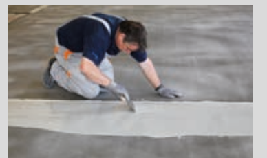
Händisches Anarbeiten an eine Dehnfuge
