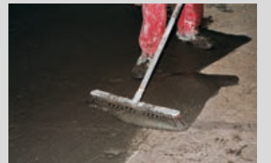
Aufbringen einer Mörtelhaftbrücke mit PCI Pecihaft®
