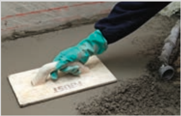
Der PCI Novoment® Schnellestrich muss frisch in frisch auf die Haftbrücke aufgebracht werden
