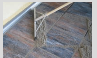
Einbringen des drainfähigen Pflasterfugenmörtels PCI Pavifix® 1K Extra auf der vorgemasteten Natursteinfläche
