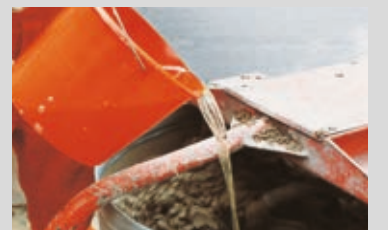
Aufbringen eines Spritzbewurfs vergütet mit PCI Emulsion
