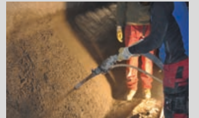
Der sulfatbeständige Reparaturmörtel PCI Nanocret® R4 PCC kann sowohl händisch als auch maschinell aufgetragen werden
