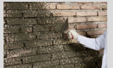
Aufbringen eines Spritzbewurfs vergütet mit PCI Emulsion
