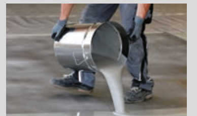
Aufbringen der Verlaufsbeschichtung
