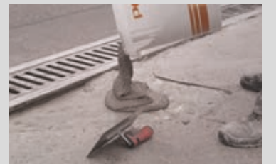
Fließfähiger Ausgleich einer Bodenfläche aus Beton mit PCI Repafast® Fluid
