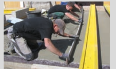
PCI Peciment® 50 auf einer Brücke nach ZTV-ING
