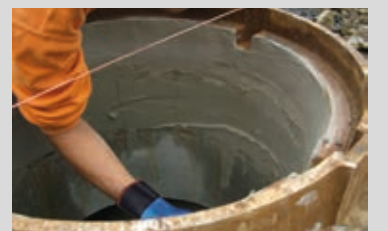
Auskleiden eines Schachtrings und Setzen mit PCI Polyfix® plus L
