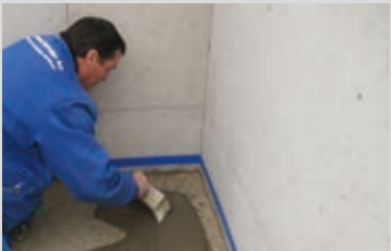
Bei Verbundestrichen ist eine Haftbrücke aus PCI Repahaft® aufzubringen
