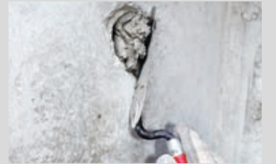
Schließen von Fehlstellen mit PCI Polyfix® 5 min. oder PCI Repafix®
