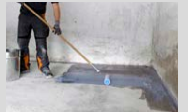
Zweimaliges Grundieren mit PCI Gisogrund® 404 (im Kreuzgang sorgt für eine sichere Haftung des Bodenausgleichs auf dem Untergrund).
