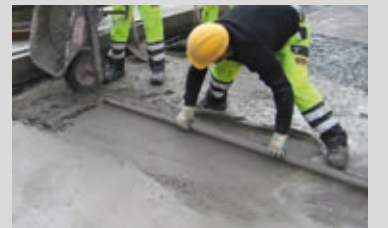
Standfester Ausgleich einer Bodenfläche aus Beton mit PCI Repafast® Tixo
