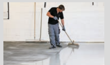
Verteilen mit Rakel und Stachelwalze
