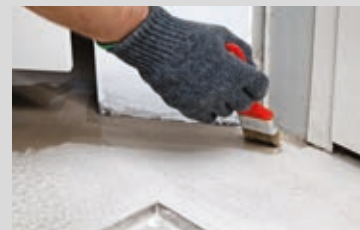
Händischer Auftrag der mattierenden Kopfversiegelung PCI Finopur®
