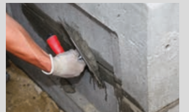
Schließen von Fugen und Angarnieren von Ecken und Kanten mit PCI Nanocret® R2
