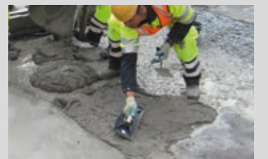
Standfester Bodenausgleich eines Betonausbruchs mit PCI Repafast® Tixo
