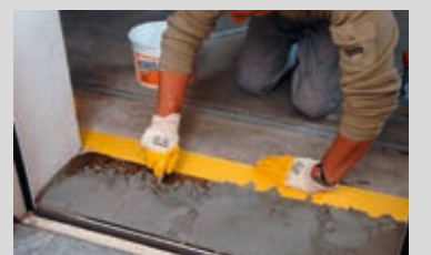
Ausgleich einer Schwelle oder Treppenstufe mit standfestem Epoxi-Mörtel PCI Aposan®
