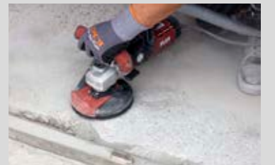
Alte Rückstände und Verunreinigungen durch Abschleifen entfernen.
