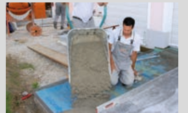
Einbau des Monokornmörtels PCI Pavifix® DM auf eine unterstützende Drainmatte
