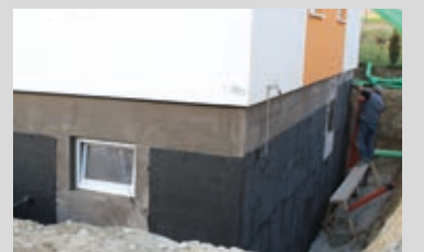
Übergang einer Schwarzabdichtung mit PCI Barraseal® Turbo über die Geländeoberkante
