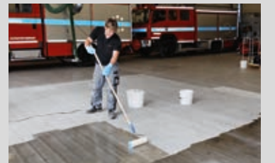
Grundieren der vorbereiteten Fläche mit Epoxidharz wie z. B. PCI Epoxigrund 390
