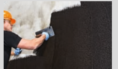
Die PCI Pecimor® Bitumen-Dickbeschichtung lässt sich leicht und kraftsparend verarbeiten
