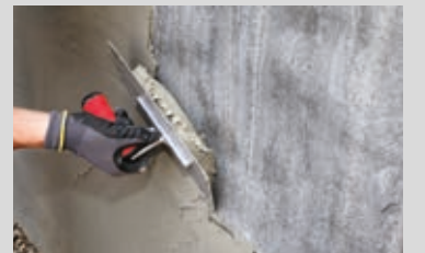
Aufbringen des faserverstärkten Feinspachtels PCI Nanocret® FC
