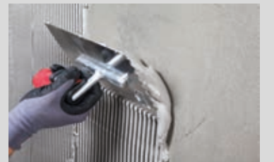
Einfache Verarbeitung: spachtel- und streichfähig, roll- und spritzbar
