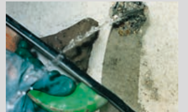
PCI Polyfix® 30 sek. als Blitz-Zement-Mörtel zum schnellen Abdichten von Wassereinbrüchen
