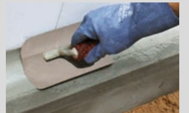
Ausbilden einer Dichtungs-/Hohlkehle am Übergang mit PCI Polyfix® plus L
