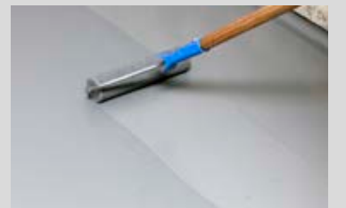
Nach zweimaligem Streichen mit PCI Supracolor ist die optische Sanierung abgeschlossen.
