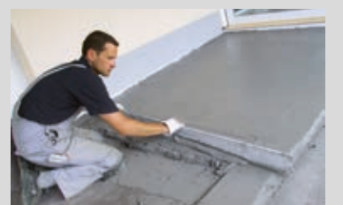
Mit Zusatzmitteln wie PCI Estrifix® und PCI Dichtungsmörtel werden die Verarbeitung und die Eigenschaften von herkömmlichen zementären Estrichen verbessert
