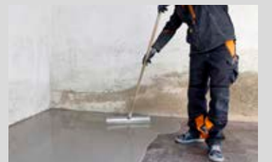
Angemischtes PCI Zemtec® 1K gleichmäßig verteilen und anschließend mit einer Stachelwalze entlüften.
