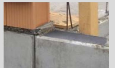
PCI Barraseal® Turbo als als Horizontal-sperre unter Wänden
