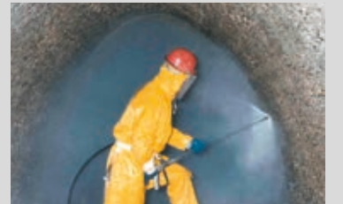
Vorbereiten einer geschädigten Betonoberfläche in einem Kanal
