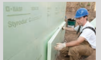
PCI Pecimor® DK vollflächig auf die Dämmplatte auftragen und verkleben. Oberhalb des Grundwasserspiegels ist auch eine Verklebung im Punktklebeverfahren zulässig. Die Stöße der einzelnen Platten mit PCI Pecimor® DK verspachteln
