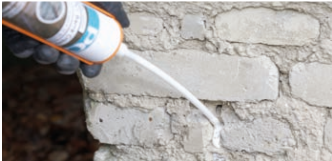
Injektion einer wasserabweisenden Horizontalsperre mit PCI Barra® Creme
