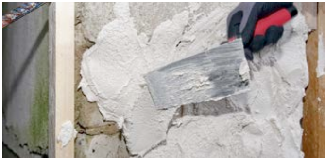
Aufbringen von PCI Saniment® 2 in 1 als Sanierputz und Feinputz in einem
