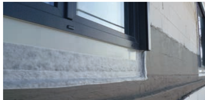
Anschluss Fensterelement mit Fixband PCI BT 42
