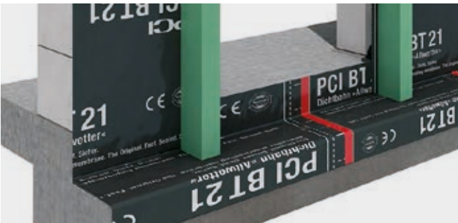
Grundabdichtung mit PCI BT 21 – bereits angedichteten Fensterdämmelement
