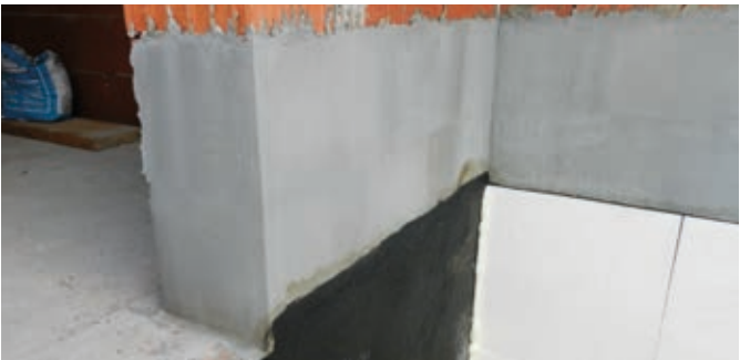
Zwischenabdichtung mit PCI Barraseal®
