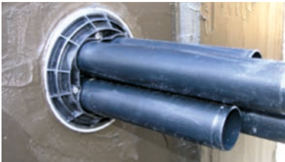
Anarbeiten von PCI Barraseal® Turbo an eine Mehrspartenhauseinführung
