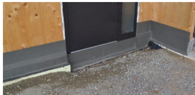
Anarbeiten der flexiblen mineralischen Dichtschlämme PCI Barraseal® Turbo an das Dichtband und Fensterelement
