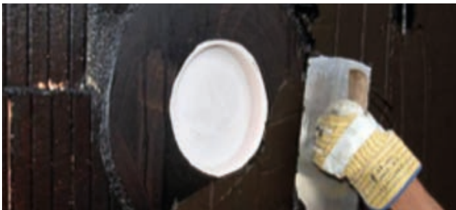
Anarbeiten von PCI Pecimor® 2K an einen Klebeflansch
