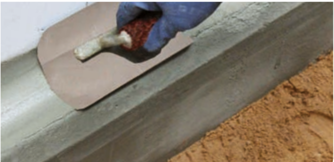
Erstellen einer wasserdichten Dichtungs-/Hohlkehlen mit PCI Polyfix® plus L
